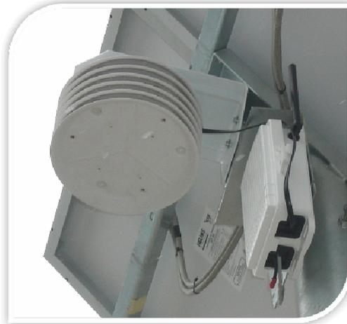
Il sistema stazione meteo integrato nelle webcam Planet, è in grado di fornire alla webcam variabili meteorologiche utilizzabili nelle immagini inviate. A seconda dei sensori che si scelgono, è possibile impreziosire le proprie immagini con informazioni di temperatura, umidità, pluviometro e anemometro integrati in un'unica struttura per la massima semplicità di montaggio.
